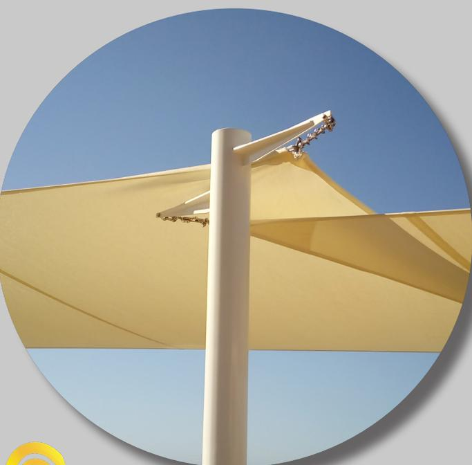
Esta vela puede **necesitar** mástiles, postes o placas, y no necesariamente por este orden. Estos elementos tensores son los que se colocan entre los postes, mástiles o placas y la vela tensada. Tensando cada uno de los lados obtenemos la tensión necesaria para su estabilidad.
